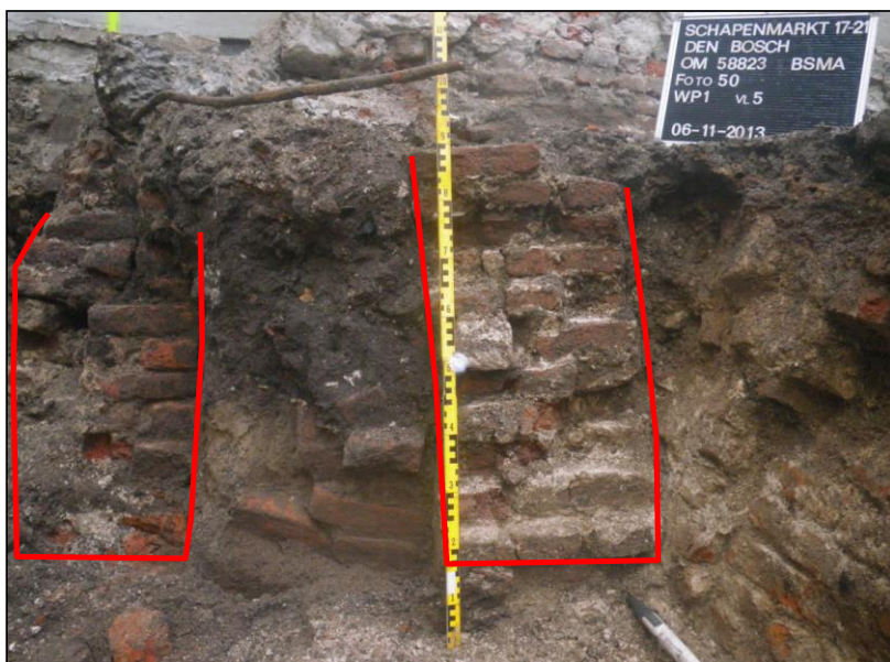
Figuur 24 De funderingen (F18 links en F75 rechts) aan de noordzijde van het perceel. Doorsnede van de funderingen richting het westen.
